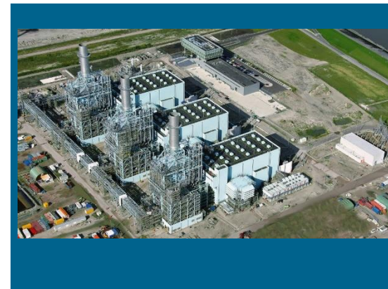
Prosjekt: Magnum gasskraftverk i Eemshaven, Nederland.
